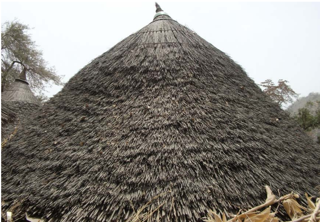
Photo 4 : Tresses de tige de mil soutenues par la charpente en bois
