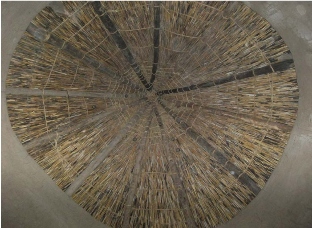
Photo 3 : charpente en bois d'une case
